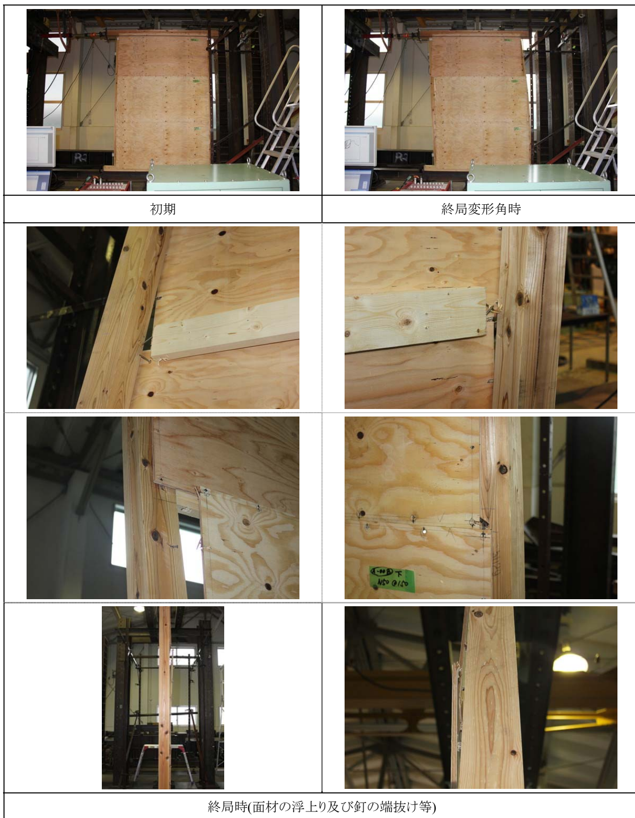
図 5-36 H-1b 損傷写真
