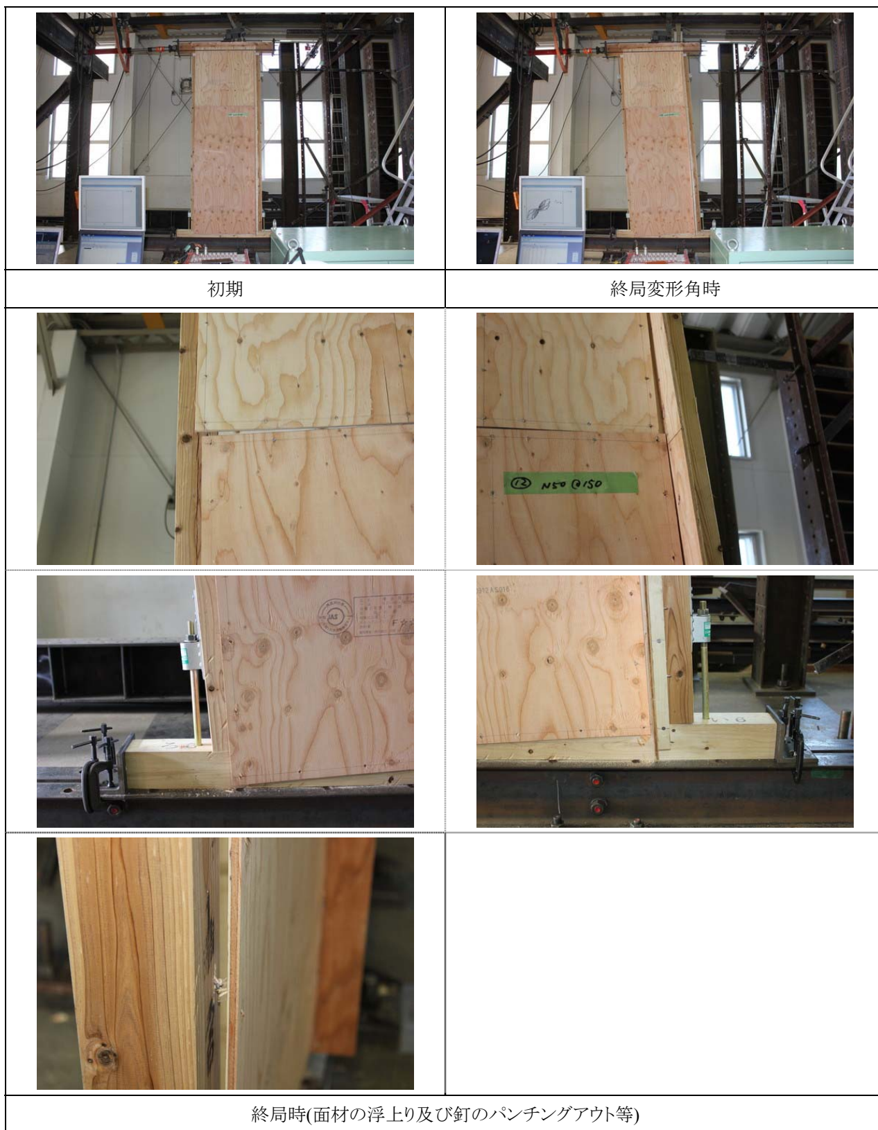
図 5-12 B-1d 損傷写真
