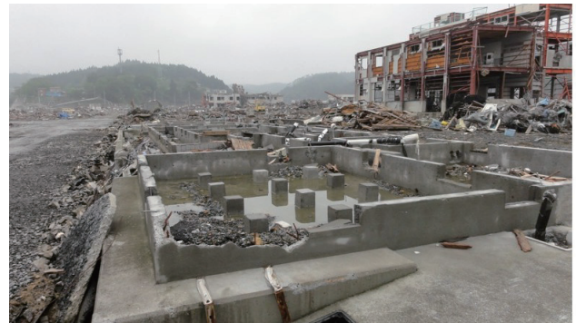
スライド1 津波による木造住宅と鉄骨の被害
