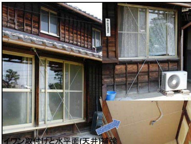
アイワン取付けと水平面(天井)補強
